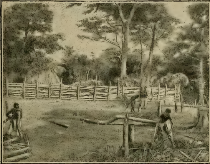
CONSTRUCTION DE LA PALISSADE.
